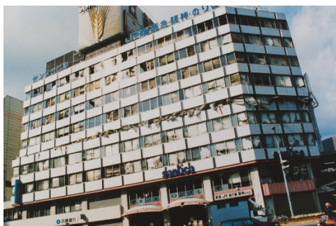
[神戸市中央区被災状況]
