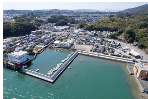
三重防護の例（高知港海岸） ※写真提供：高知県
